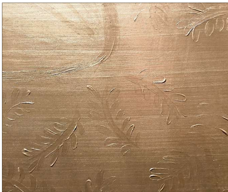
Sorgfältig erstellte Struktur für die Decke.
